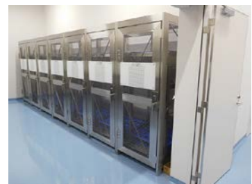
図4 燃料棒保管庫
