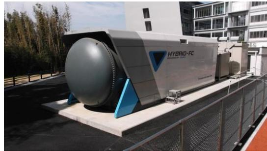
図.2 産業用複合発電システム（250kW級）
